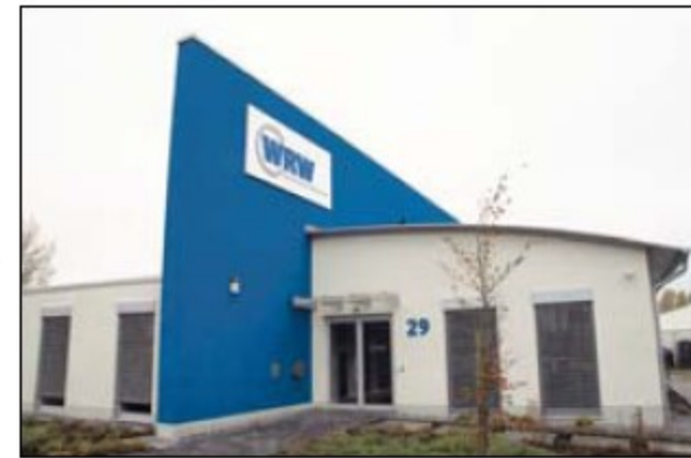
34 Mitarbeiter sind mittlerweile bei WRW an der Kruppstraße 29 beschäftigt.
